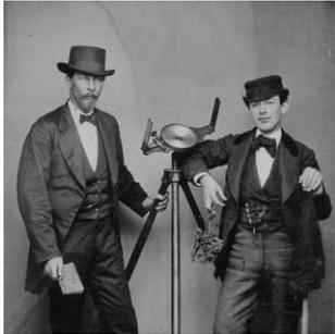
En esta foto tomada alrededor de 1870 se observa a un agrimensor y cadenero con una brújula a vernier fabricada por Levi Colton.
